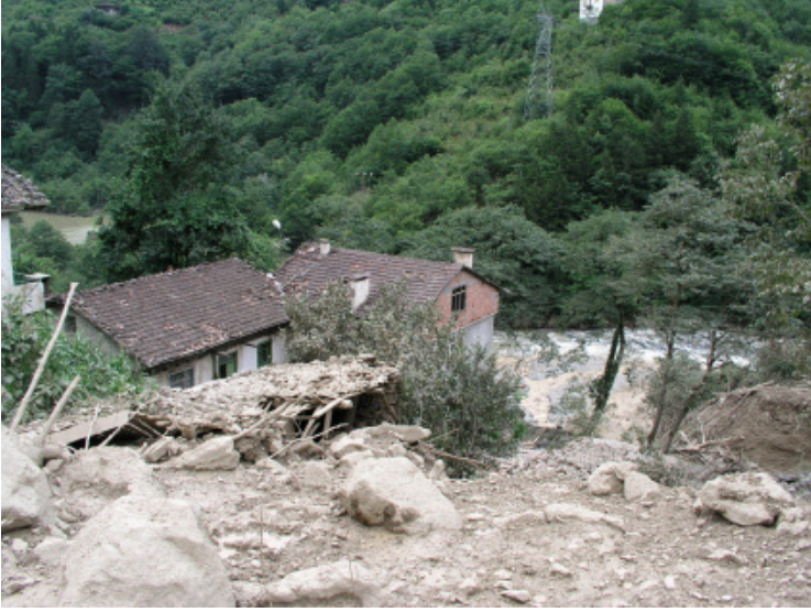
Serdarlı ırmağının yatağında bulunan yerleşim yerindeki binaların durumu
