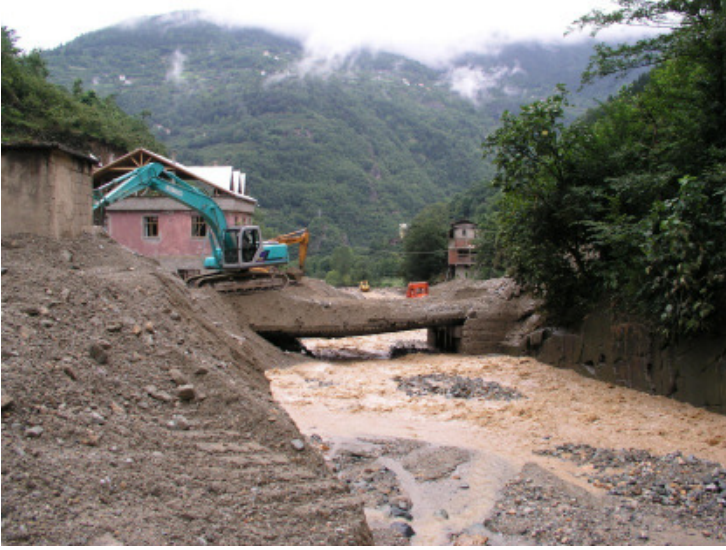
Gümüşdere mahallesine giden yolun üzerinde bulunan köprünün tekrar trafiğe açılabilmesi için çalışmalar sürdürülüyor.
